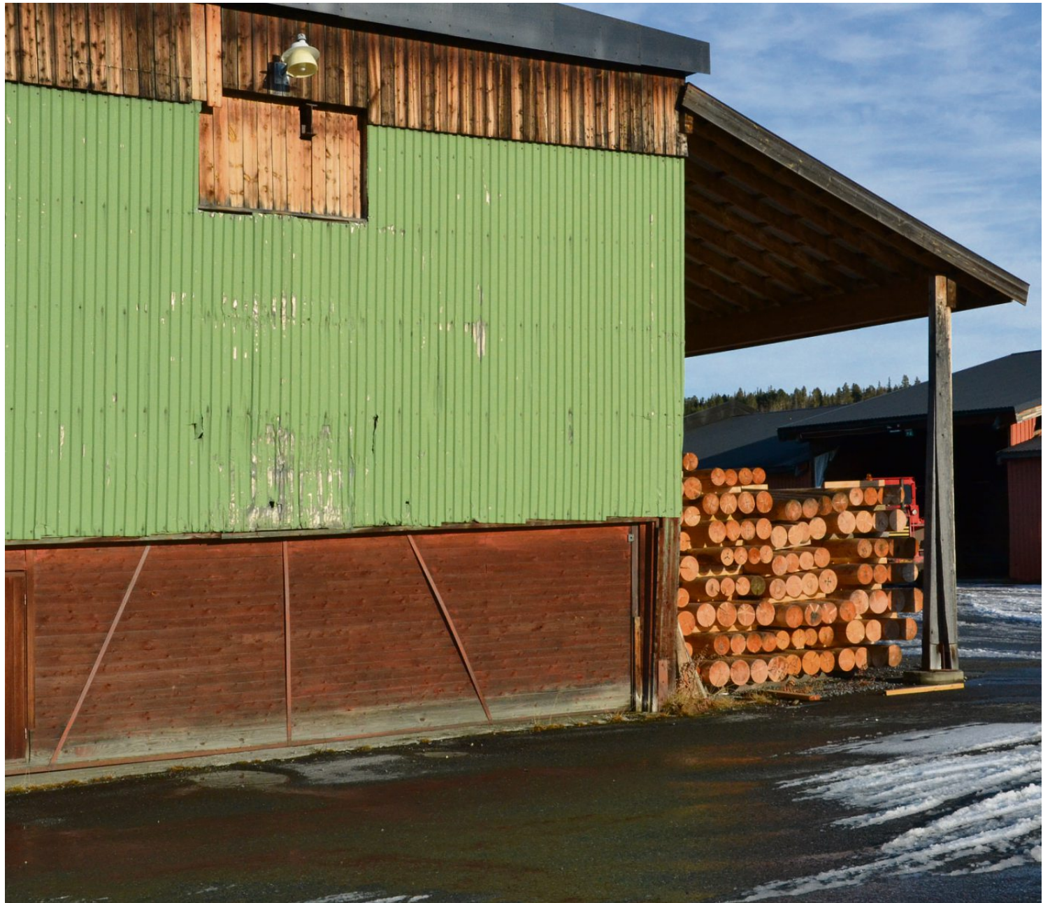
Det er dette lagerbygget Sande Hus og Hytter på grunn av plassmangel ønsker å disponere også i fremtiden. I bakgrunnen ser vi det nye kombinerte administrasjons- og produksjonsbygget. Foto: Jan Inge Flå
